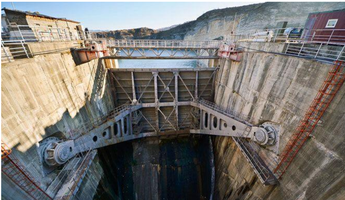
Рисунок 26 - Сегментный затвор
