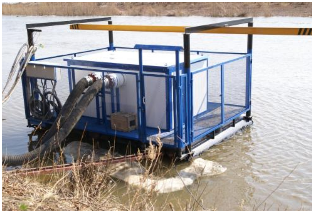
Рисунок 60 - Плавучая насосная станция.
