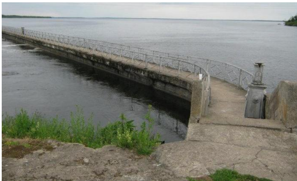
Рисунок 38 - Льдозащитная стенка с пешеходным проходом по ней (г. Ивангород)
