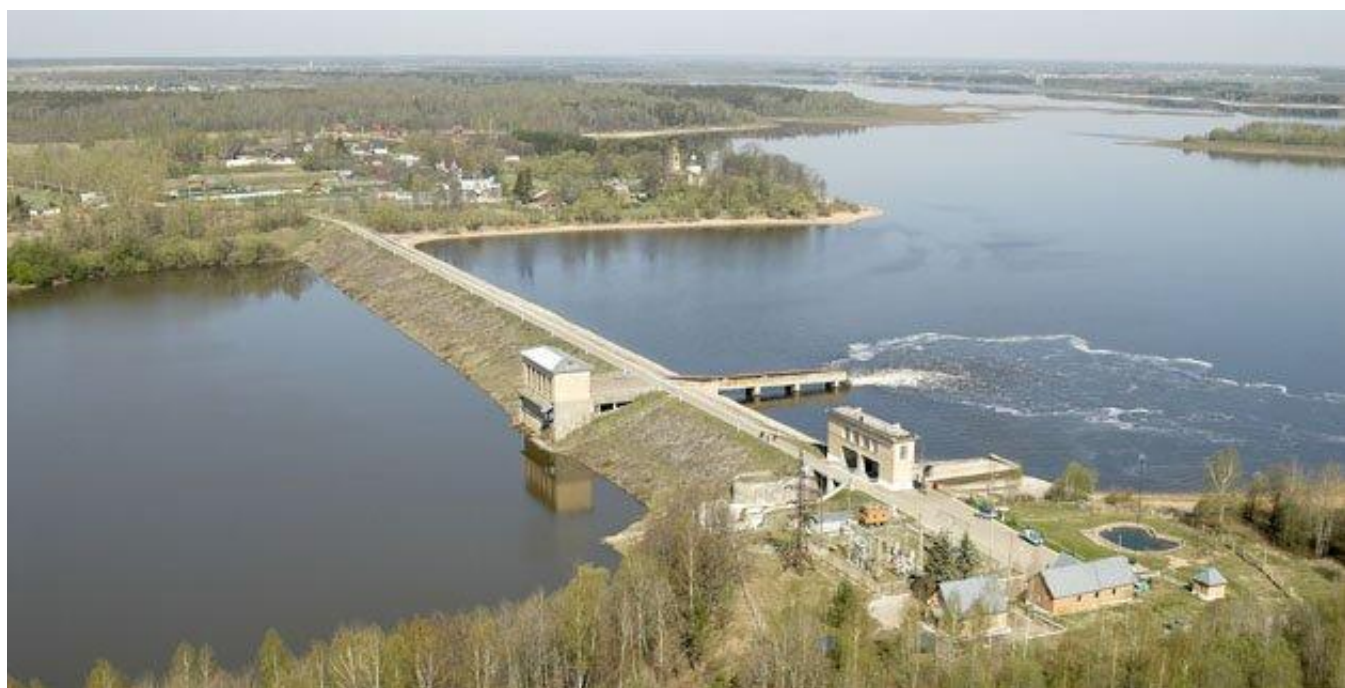
Рисунок 5 - Акуловский гидротехнический узел
