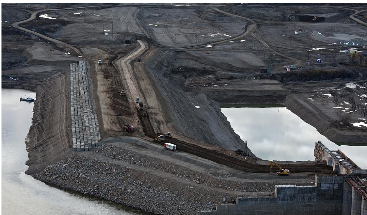
Рисунок 7 - Возведение земляной плотины Усть - Среднеканской ГЭС
