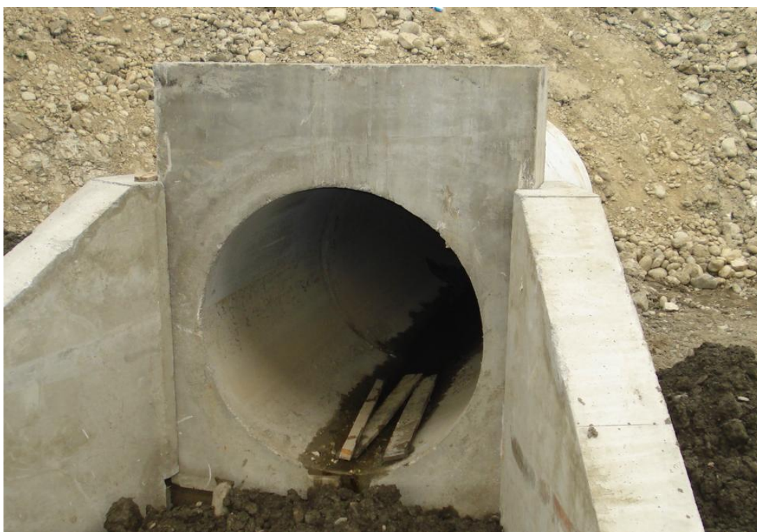
Рисунок 16 - Водопропускное сооружение
