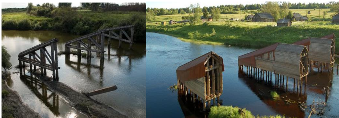
Рисунок 36 - Льдозащитные устройства
